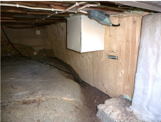
Krypgrund 2: Ny vägg för den tidigare öppningen
