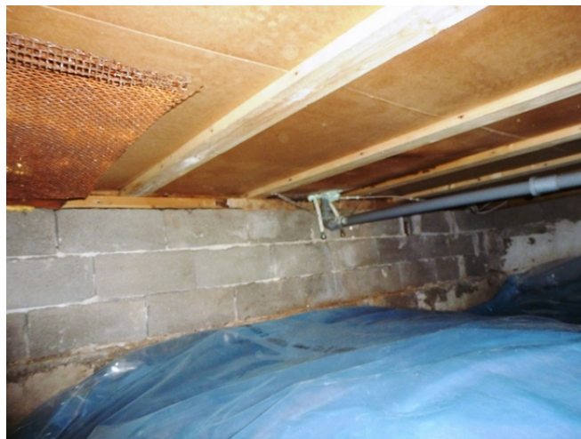
Krypgrund 1: Utbytt sylldel och lagat hål under diskbänk
