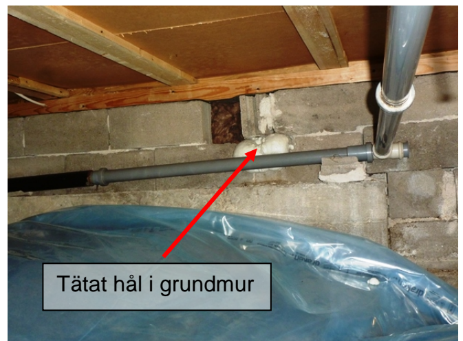
Krypgrund 1: Hålet tätades med byggsaum på insidan
