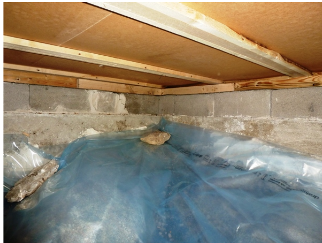
Krypgrund 1: Utbytt sylldel
