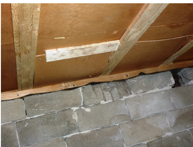
Krypgrund 1: Utbytt isolering och blindbottenskiva
