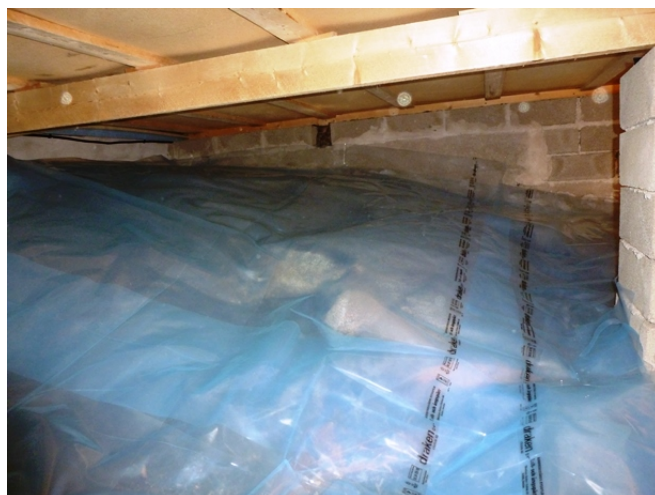
Krypgrund 2: Avplastning mot mark
