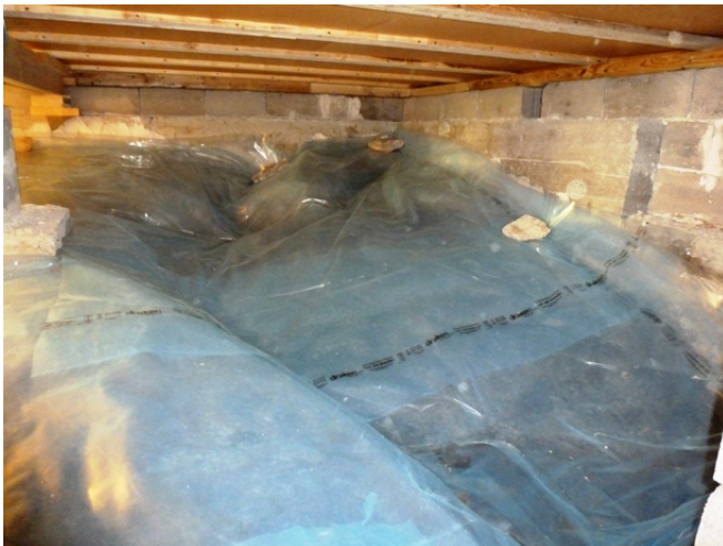
Krypgrund 1: Avplastning mot mark
