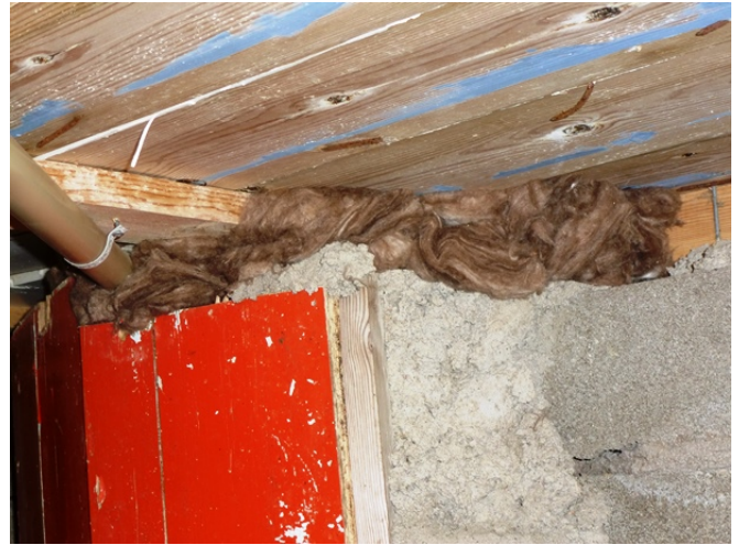
Krypgrund 2: Tätning av hål
