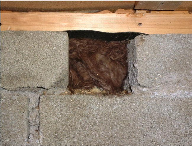
Generellt: tätning av alla ventiler
