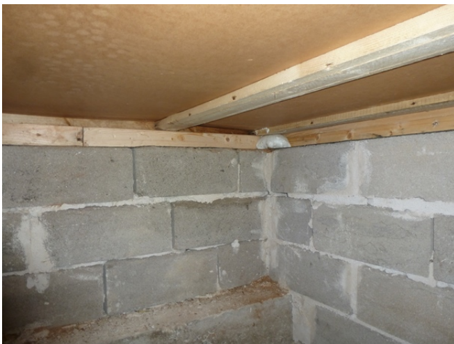
Krypgrund 1: Utbytt sylldel
