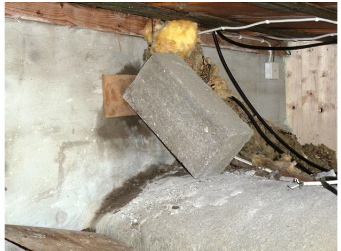
Krypgrund 1: Hålet i grundmuren murades för med cement på utsidan
