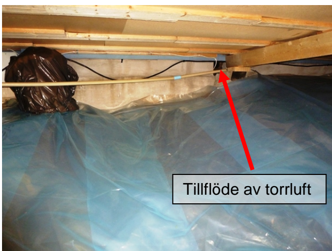
Krypgrund 2: vägg mot krypgrund 1
