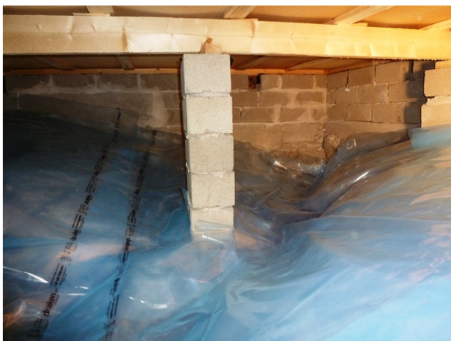
Krypgrund 2: Avplastning mot mark
