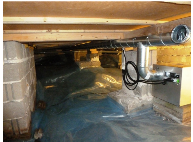
Krypgrund 1: Installation av sorptionsavfuktare
