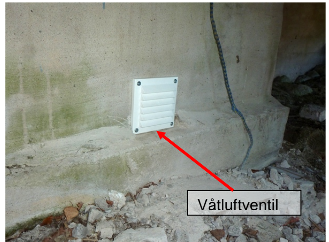
Krypgrund 1: Installation av sorptionsavfuktare
