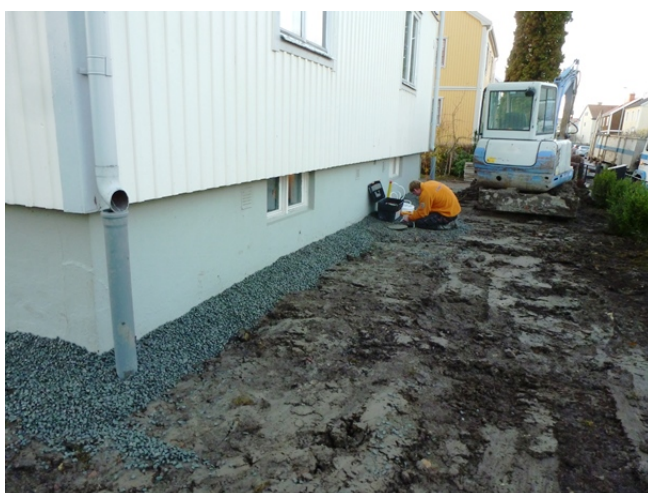
Koppling av el till dräneringspumpen
