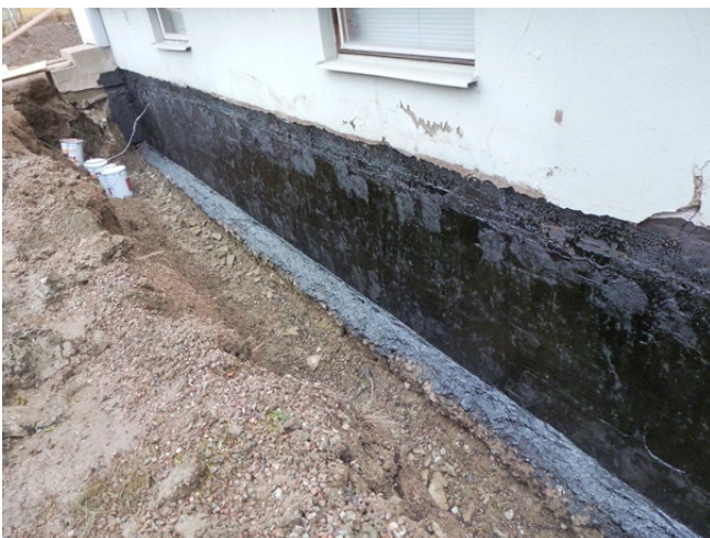
Hela grundmuren primas och appliceras med två lager bitumenmassa.
