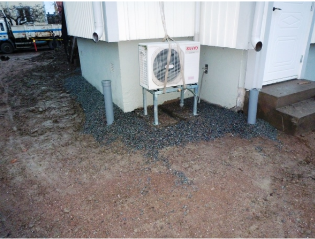
Alla takvattenrör anslöts sedan med självrensande lövsilar till det nya dagvattensystemet
