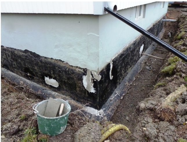
Sprickor och skador i grundmuren lagas.
