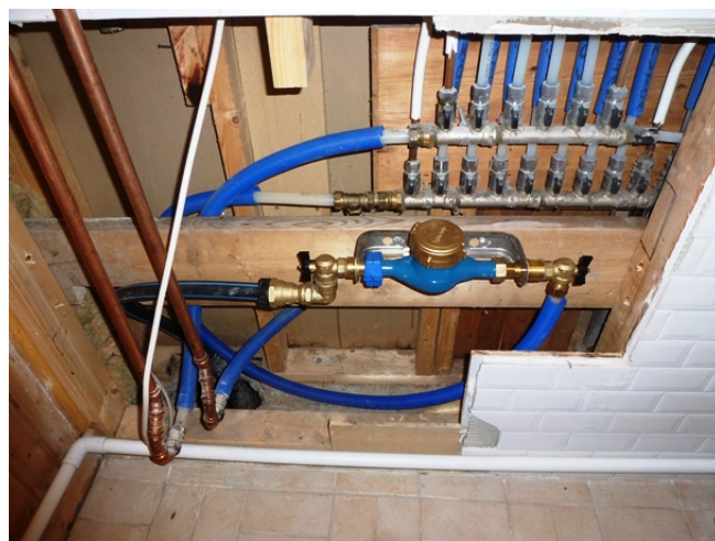
Nytt mätarkoppel till ny inkommande kallvattenledning.
