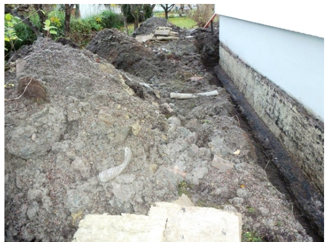
Uppgrävt schakt på baksidan
