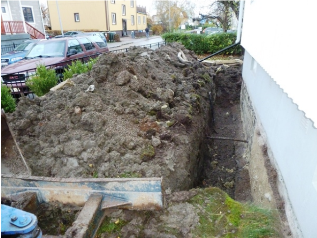
Uppgrävt schakt mot gatan
