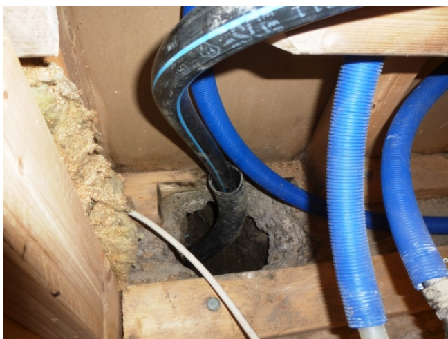
Ny inkommande kallvattenledning, rör-i-rör för ev. framtida byte utan uppbygning av golv.
