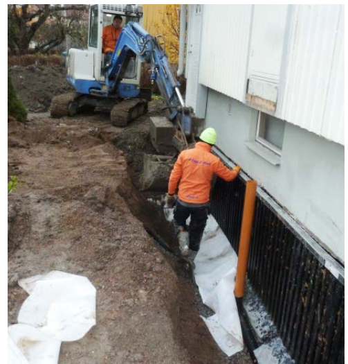
På fiberduken återfylls sedan schaktet med den tidigare uppgrävda jorden. Större stenar och skräp är dock bortsorterat.
