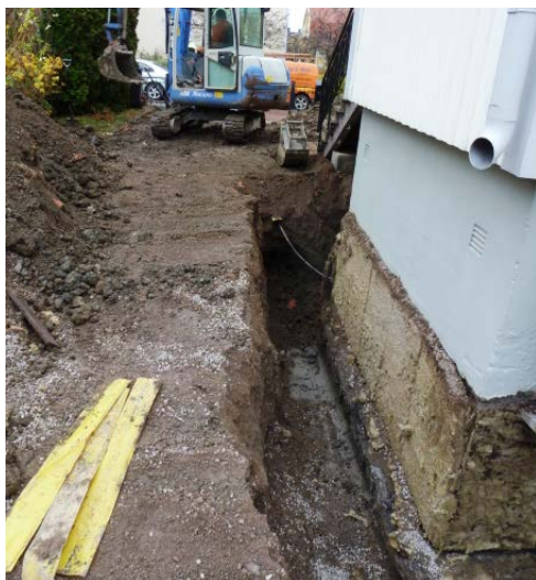
Uppgrävt schakt på entrésidan
