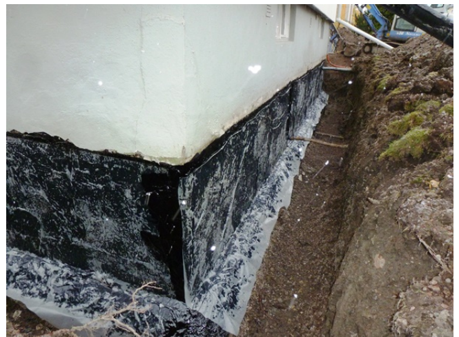
Plastfolie sätts utanpå vilket gör bitumenmassan mycket åldersbeständig, fukt- och vattenavvisande.
