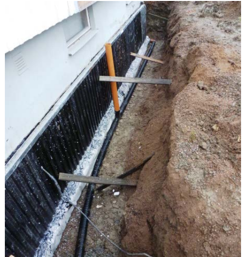
Schakt mot trädgården: Termogrund och dubbelväggigt dräneringsrör med spolrör
