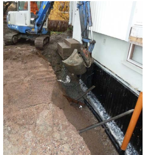
Dräneringsröret omsluts med tvättad singel.
