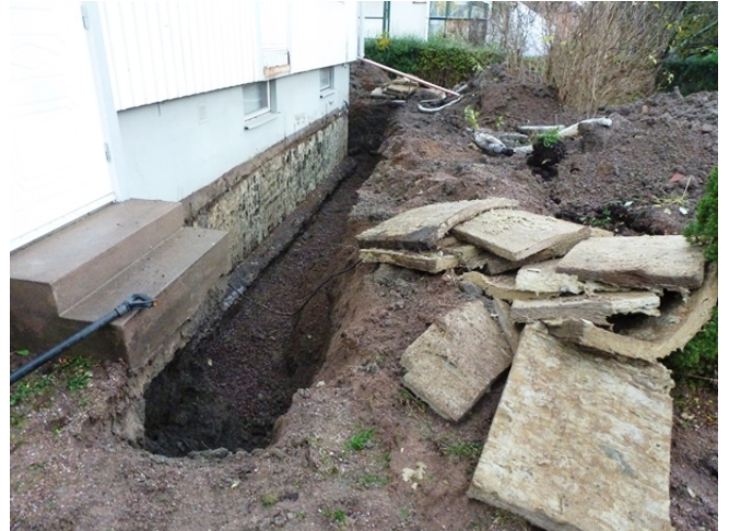
Uppgrävt schakt mot trädgården, borttagning av markskivor som varken håller fukt eller kyla borta men dock utgör ett mekaniskt skydd stenar etc.
