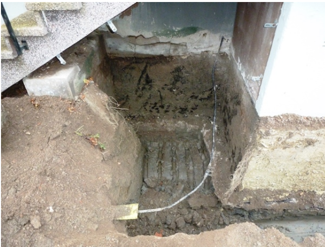
Uppgrävt schakt under entrétrappan. Här går även inkommande elkabel in
