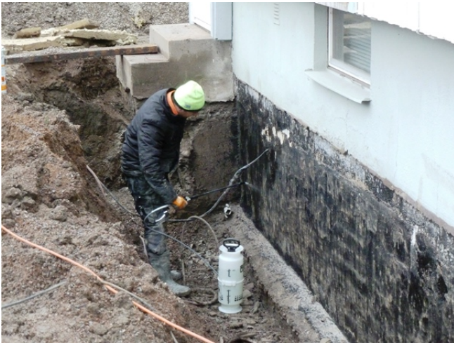
Hela grundmuren rengörs med MVOC-Desinfektion®. Jordbakterier och lukter elimineras.
