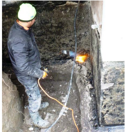
Hela grundmuren gasoltorkas.
