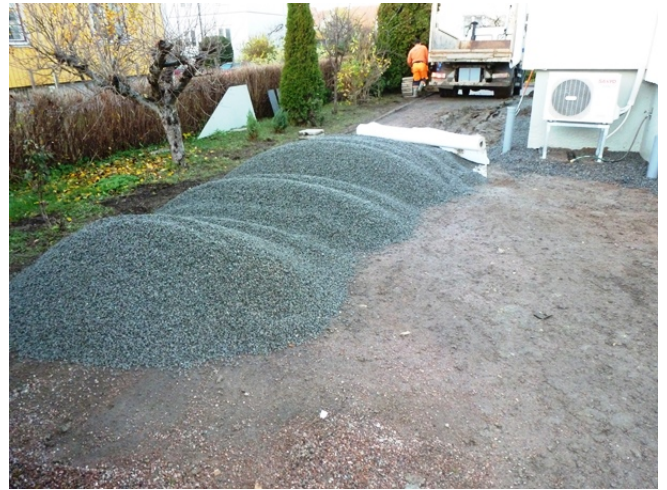
Gårdsinfarten grusades med underliggande markfiberduk.
