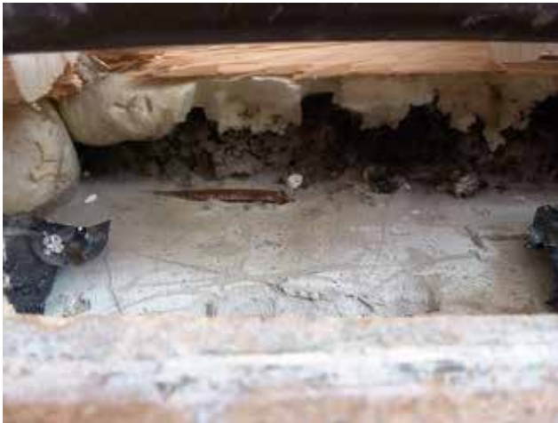
Konstruktion vid ytterväggs syll. Lecablock, fogsium, platonmatta, golvspackel
