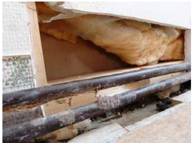
Konstruktion av yttervägg.
