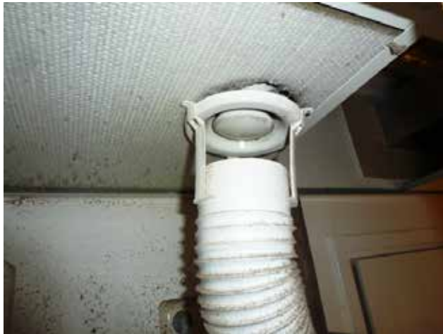
Torkskåpens frånluft mynnar vid utsug. Bristfällig lösning.
