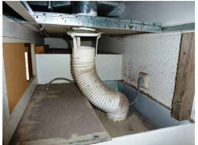
Torkskåpets ovsida. Stora mängder smuts och damm
