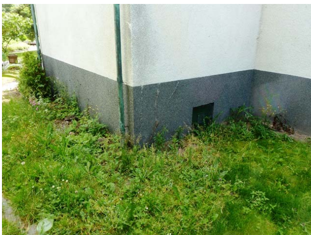
Lucka till krypgrund under entrén
