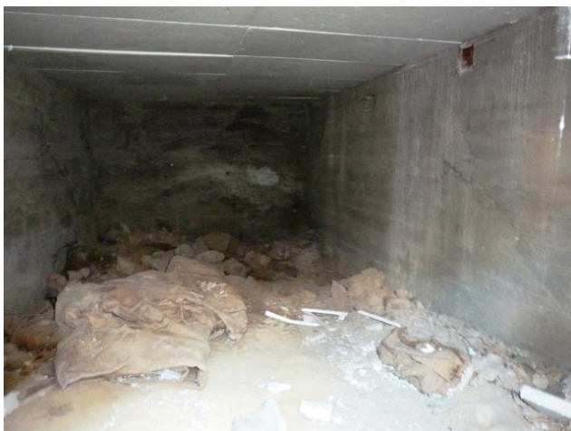
Krypgrund under entrén: utan anmärkning
