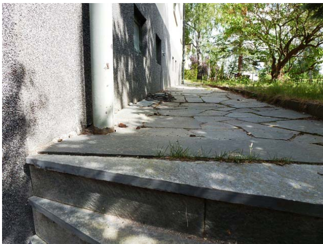
Stenplattorna motverkar att större mängder nederbördsvatten rinner ned vid husgrunden
